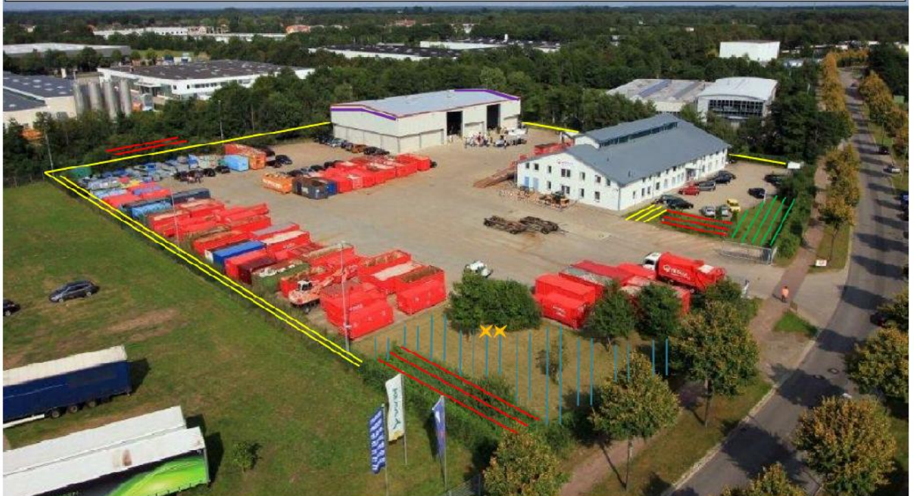
Naturschutzfachliche Maßnahmenvorschläge des NABU auf dem Gelände des Abfallsammelbetrieb von Veolia Umweltservice in Neumünster
